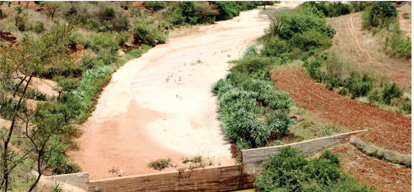
Uma barragem de areia é uma parede de betão armado construída ao longo de um leito de rio sazonal. Durante as estações chuvosas, água e areia são capturadas atrás da parede da barragem de areia. A água escorre pela areia presa, formando um reservatório do qual a água pode ser levada por canos e bombas.
