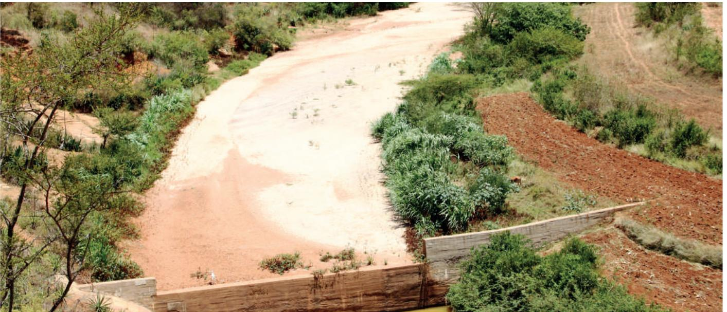
Un barrage de sable se compose d'un mur de béton renforcé bâti en travers d'un lit de rivière saisonnière. Au cours de la saison des pluies, il permet de recueillir l'eau et le sable derrière son mur. L'eau s'écoule progressivement à travers le sable piégé et fournit un réservoir à partir duquel il est possible d'obtenir de l'eau par le moyen de tubes et de pompes.
